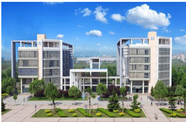
本科生实验楼
