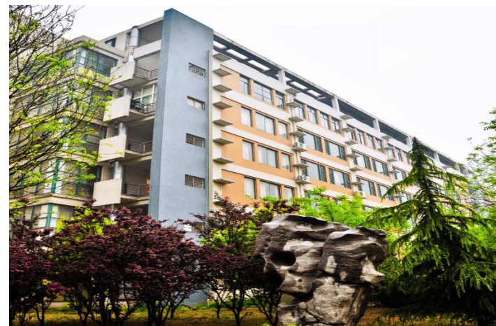
生物工程学院教学实验楼
